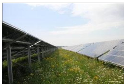
Abb.14: Beispiel für aufgeständertes Modulfeld
