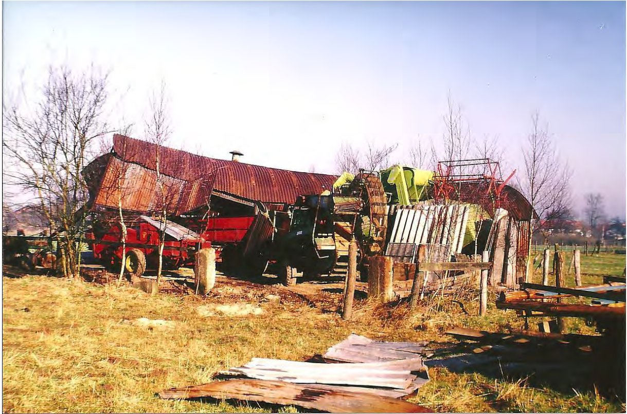
1990, Februar Roth: Sturm zerstört die Maschinenhalle von Fegmeier
