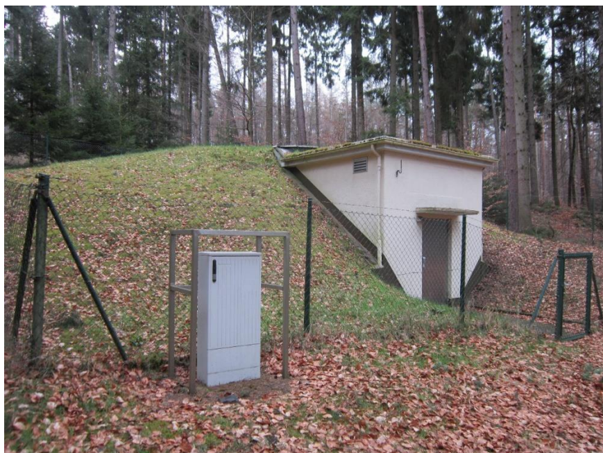
Neues Wasserhaus oberhalb v. Kreisjugendheim im Wald bei Wolfshausen erbaut 1957
