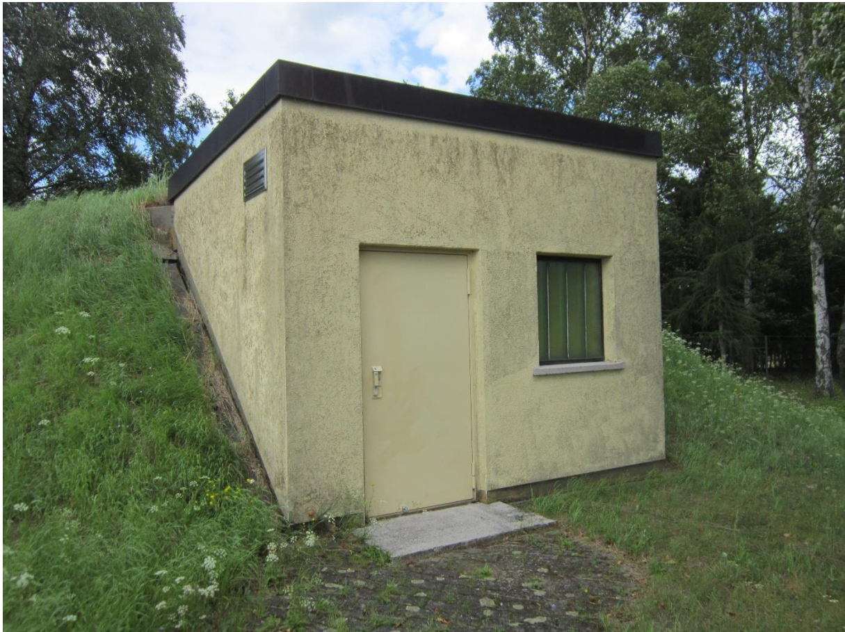
Wasserhochbehälter in Roth auf dem Geiersberg
