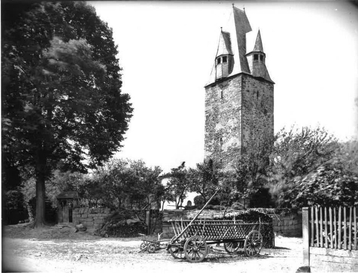
Kirche und Kirchhof in Wenkbach vor dem Abbruch des romanischen Langhauses (vor 1901, Bildarchiv Foto Marburg)
