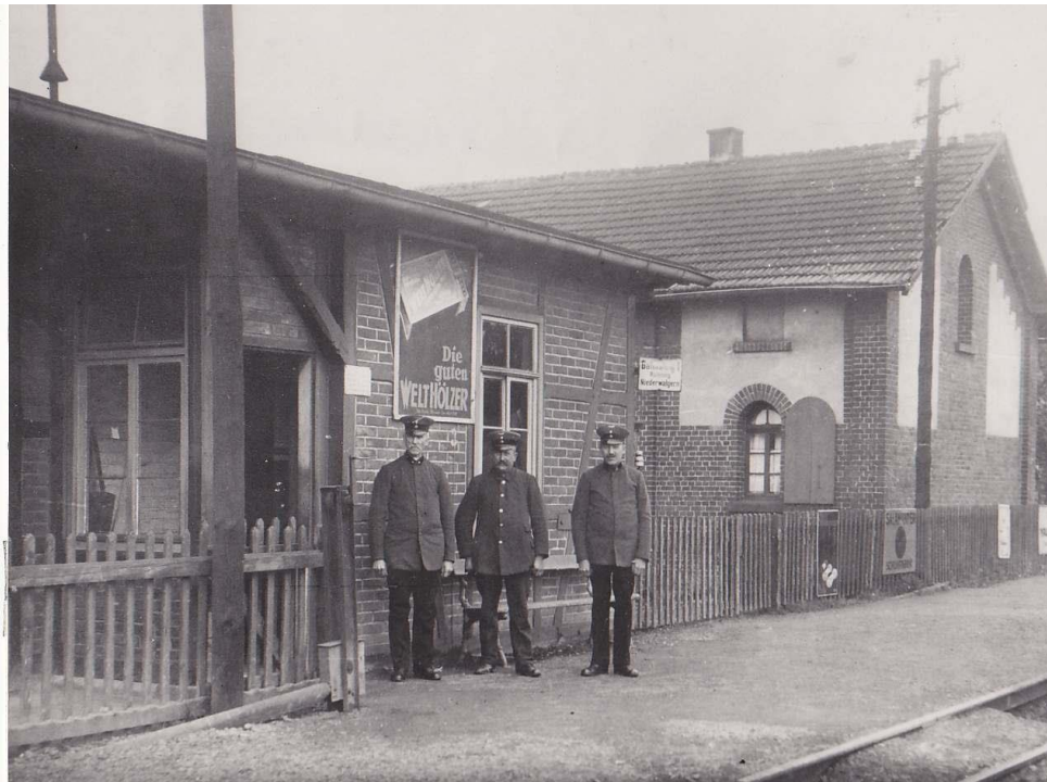
Bahnhof Niederweimar, Bild von 1935. Der Bahnhof wurde durch Fliegerangriffe im Oktober und November 1944 stark zerstört. Er wurde wiederaufgebaut und im Jahr 1968 stillgelegt.
