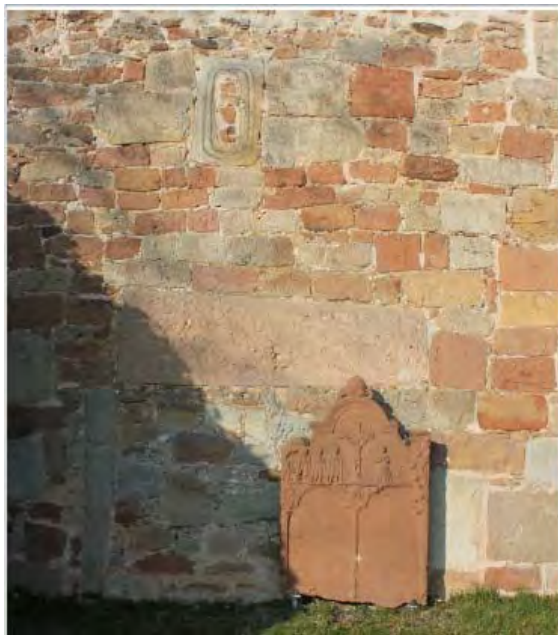
Gemeindesaal, Südwand. Romanisches Fensterchen (oben), romanische Grabplatte (horizontal darunter), 03.2014
