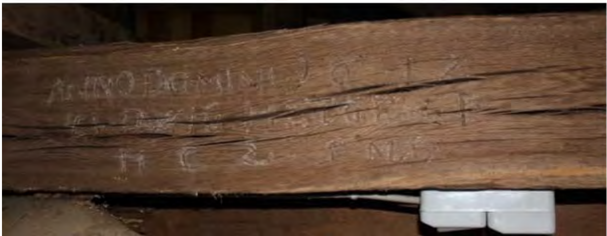
Inschrift im Dachwerk; Foto um 90 Grad nach links gedreht, 03.2014
