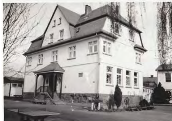
Die 1913 in der Herborner Straße errichtete Schule.
