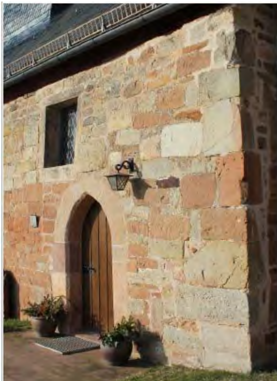
Haupteingang von Südosten, 03.2014
