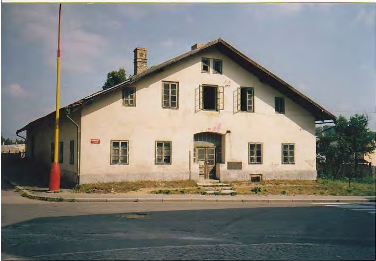
Wohnhaus Meindl in Böhmen. Ein geräumiges schönes Wohnhaus mit angrenzenden Stalleinrichtungen der Familie Meindl, in dem auch eine Töpferei untergebracht war. Die Aufnahme entstand bei einem Besuch der Familie Meindl im Jahr 1980. Der Verfall des Gebäudes, der in den kommenden Jahren zunahm, ist hier schon zu erkennen. Bei einem weiteren Besuch der Familie war nur noch ein Haufen Bauschutt zu sehen.
