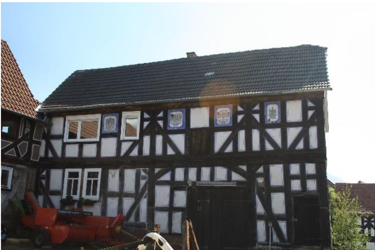
Der Wohn- und Wirtschaftsbaus auf Gebannhönges -Hof, bauzeitlich als Tordurchfahrt genutzt (Alle Fotos dieses Beitrags: Katharina Müller 2021)
