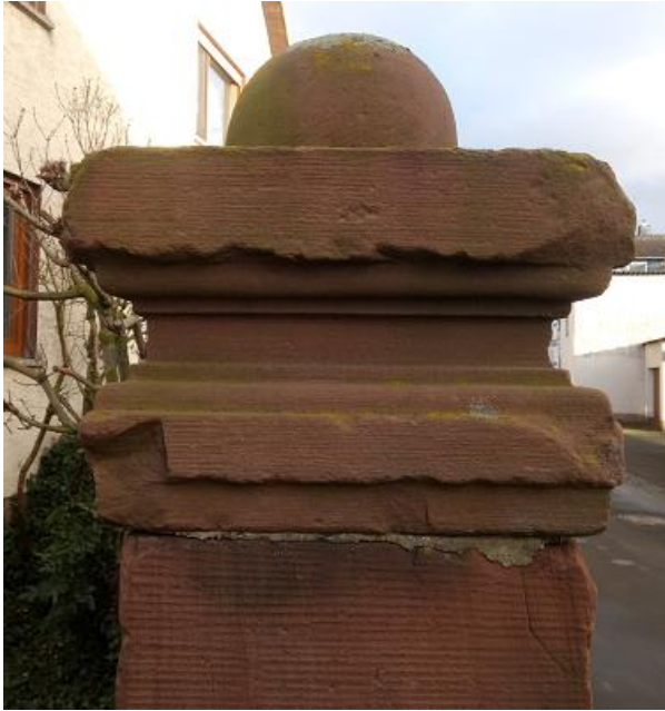
Pfeilerkopf vor Haus Nr. 5, Hauptstraße
