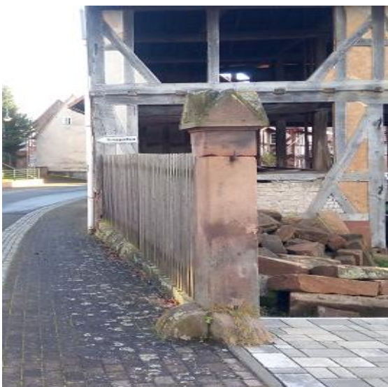
Hof-Ein- oder Ausfahrtsposten mit Prellstein von Haus Nr. 13 am nördlichen Ortsausgang von Wolfshausen
