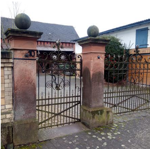
Pfeiler vor Haus Nr. 10 mit Kopfplatte, aufgesetzter Kugel als Verzierung, zugleich Träger des schmiedeeisernen Tores, Hauptstraße
