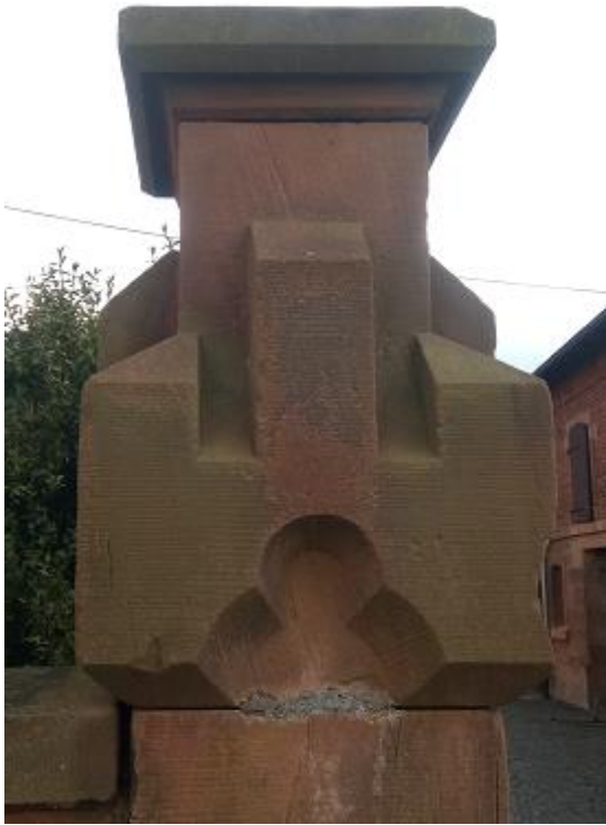
Pfeilerkopf vor Haus Nr.4, Hauptstraße, Steinmetzarbeit, Maßwerk mit geometrischem Muster, Ornamentdetail und Abschlussplatte
