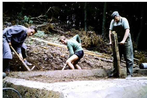
Das Fundament ist gelegt (Fotos: Slg. Hettche)
