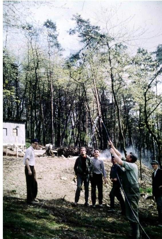
Hurra! Aus der neuen Leitung kommt Wasser
