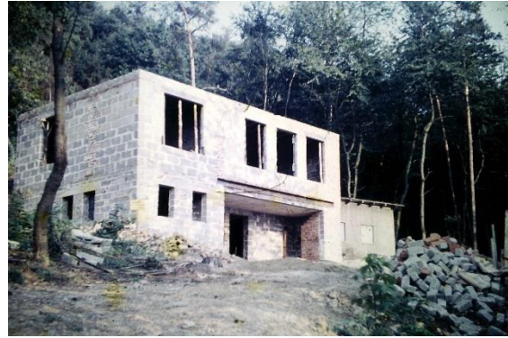
Der Rohbau wächst empor!
