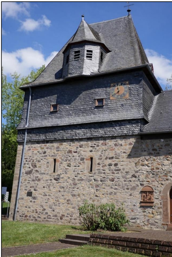
Der Wehrturm der Kirche von Salzböden (Foto: K. Krantz 2020)
