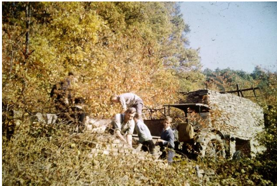
Der Abbruch der alten Ziegelei
