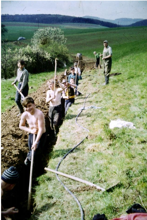
Der Graben für die Wasserleitung
