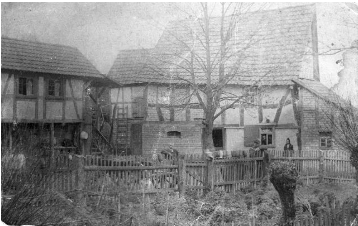
Das ehemals Naumannsche, von Johannes Stingel (Deis) zum Mühlengebäude umgenutzte Wohnhaus der Niederwälder Mühle (Foto um 1900, aus dem Privatbesitz von Elisabeth Wenz); das Obergeschoss ist noch in der Bauweise des 17. Jahrhunderts mit den gekrümmten Streben und dem hohen, bauzeitlich strohgedeckten Dach erkennbar. Ludwig Naumann hatte sich nach dem tätlichen Überfall noch schwerverletzt nach Hause schleppen können und starb acht Tage später.
